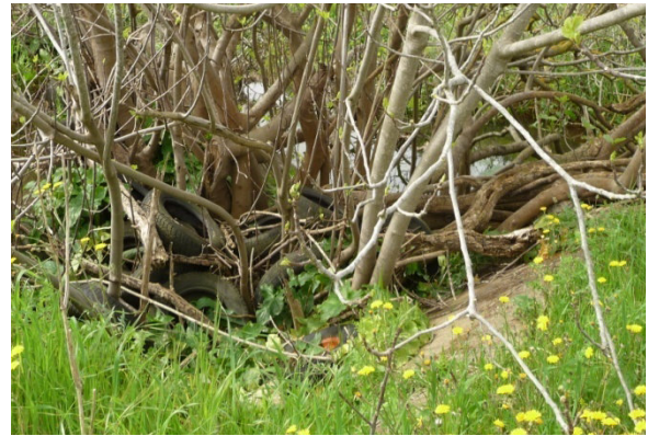
canale di sgrondo ostruito
